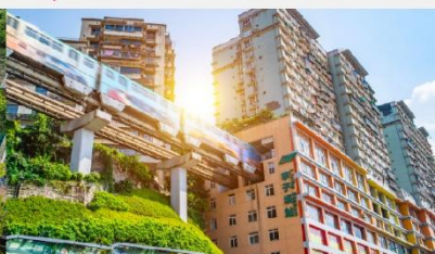
รถไฟฟ้าลู่ติง
