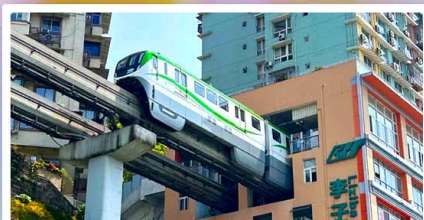
รถไฟฟ้าลัดติค
